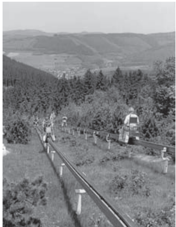
Carril unipolar aislado U 20 Electrificación en un Parque de atracciones
