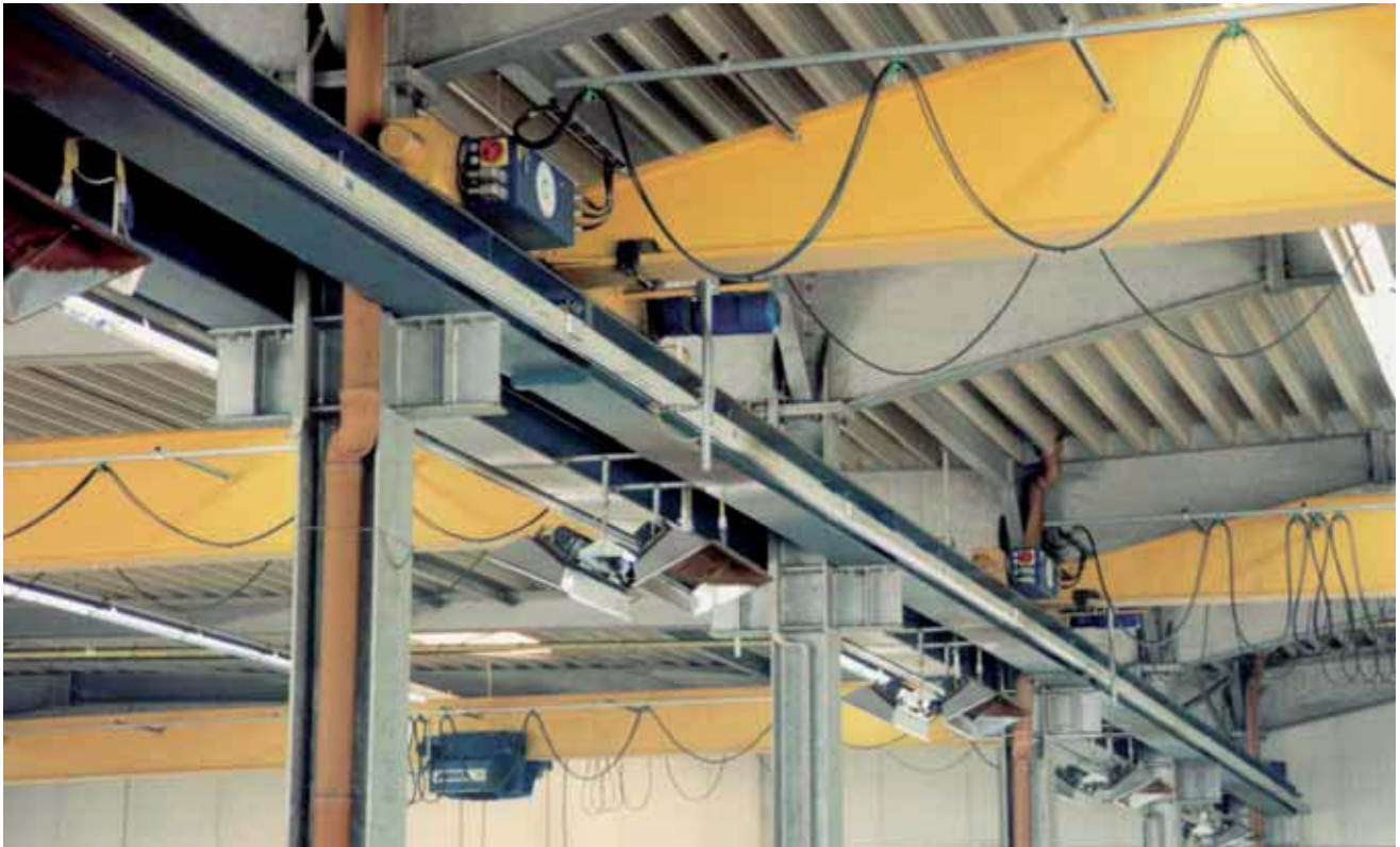
Sicherheits-Schleifleitung LSV für Hallenkrane.
